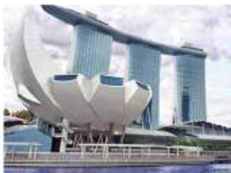
(図 3-13-8) アートサイエンスミュージアム外観 1102
