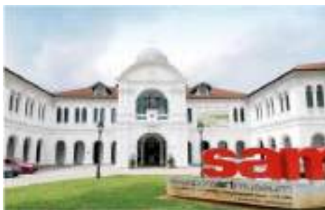
(図 3-13-7) シンガポール美術館外観（改修工事前） 1101
